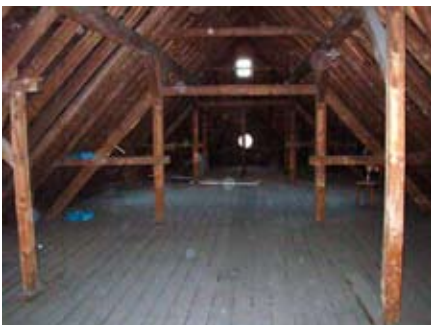
Spitzboden vor einer energetischen Modernisierung
